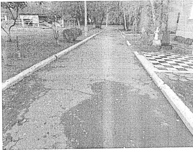
Фото 7 – прилегающая территория к зданию
